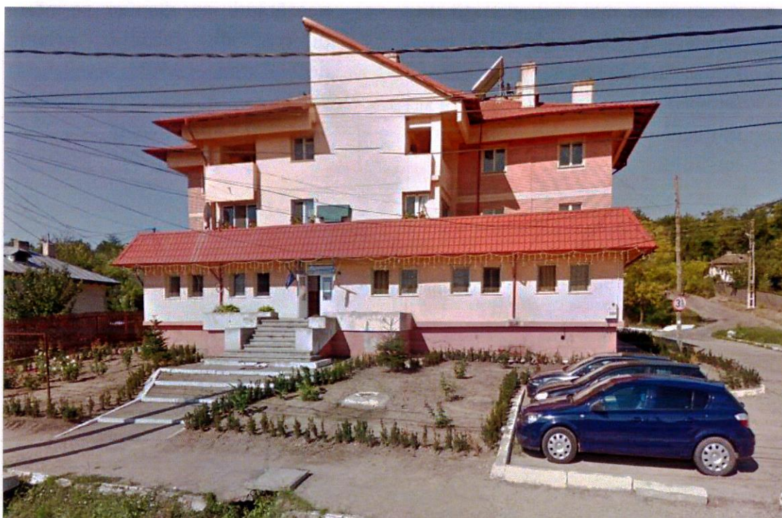
Figura nr. 41. Sediul Primăriei Frumușița
